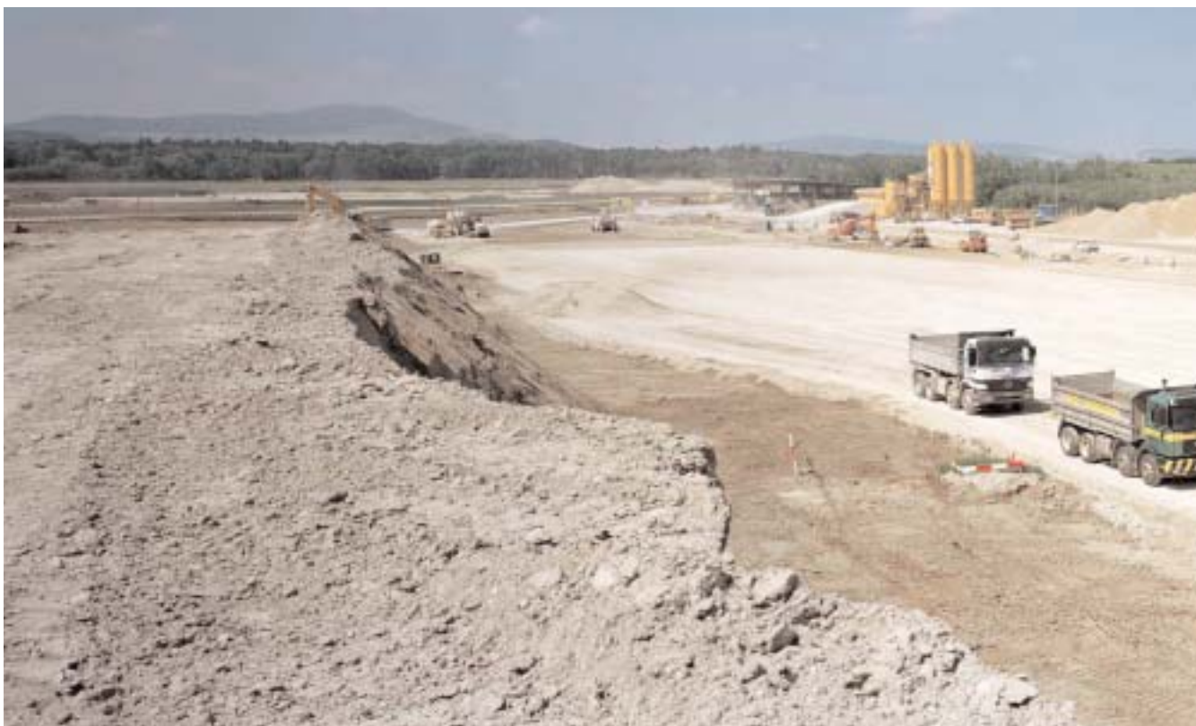
Abb. 4: Aushubdepot im Midfield
