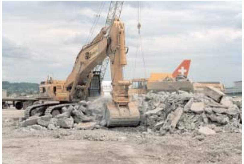
Abb. 5: Abbruch der Betonpiste
