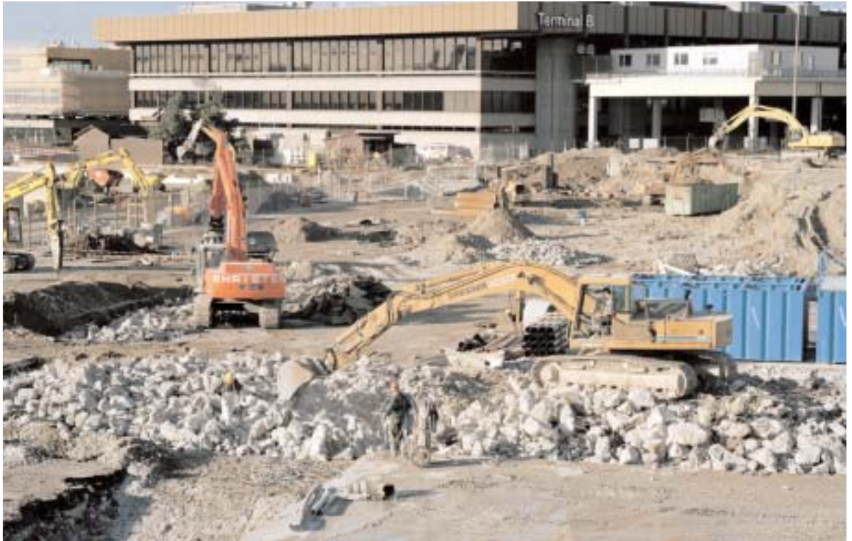
Abb. 2: Bauabfälle aus Abbrucharbeiten
